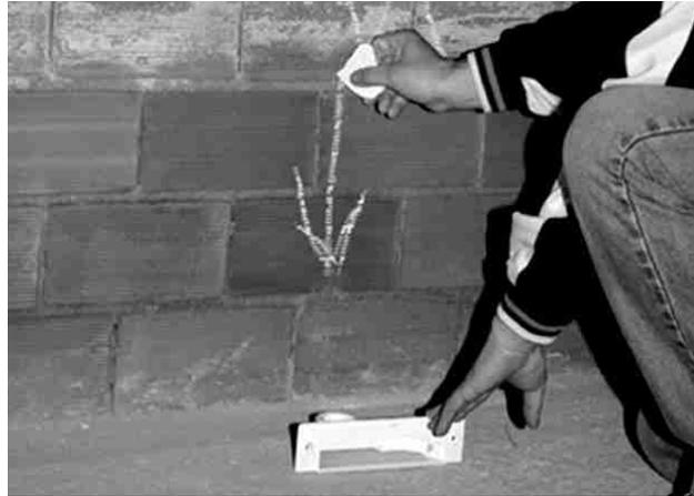
Podemos proceder al marcado de las rozas (o regatas) y pases de tuberías según anteriormente diseñamos la instalación, teniendo especial cuidado de que la previsión de la toma de cenefa no quede donde pueda estorbar a un electrodoméstico (lavadora, lavavajillas, etc.).
